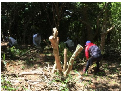
伐採したアセビの処理
