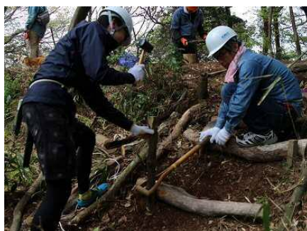
リーダーの指導による階段の敷設
