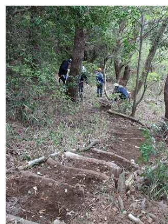
完成した活動地入口の階段
