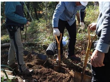
畔シート張り 作業開始
