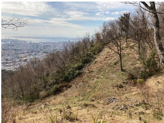
作業後の谷筋
