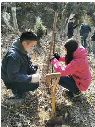
保護ネットの取付け
