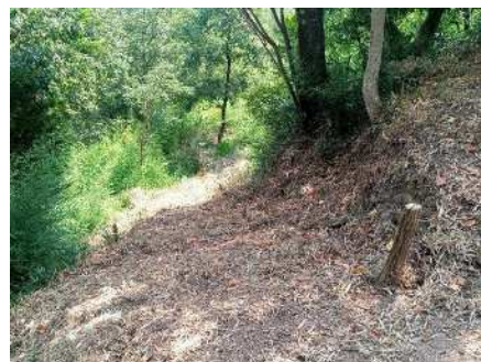
植樹予定エリアへの通路整備
