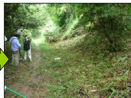
作業後の状況
