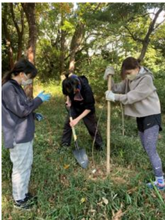
土の埋め戻し
