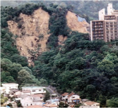
住吉台の山腹崩壊
