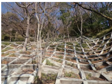
樹木を残した法枠工
