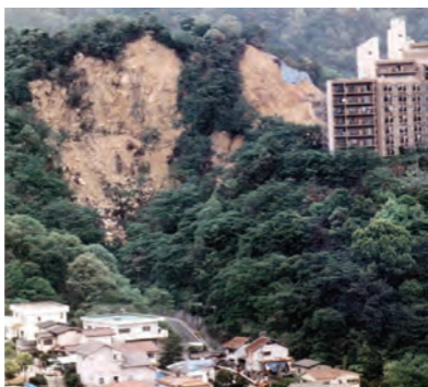
住吉台の山腹崩壊
