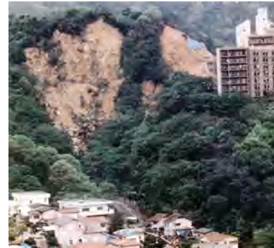
住吉台の山腹崩壊
