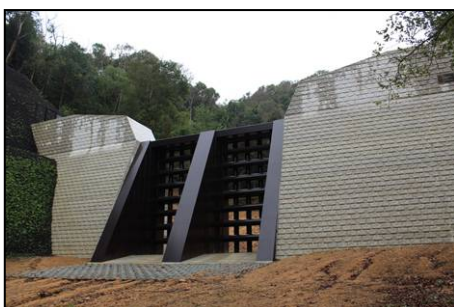
←交流の森入り口横に完成した 砂防堰堤は、土砂災害から 市民を守ります！
