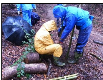
ウッドガードの取り付け
