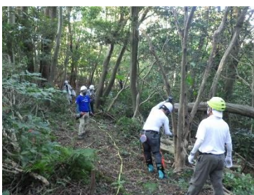
管理道の延伸作業
