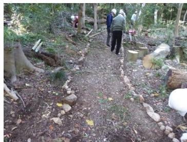
管理道の修復
