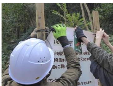
ロープワークでパネルを取付け
