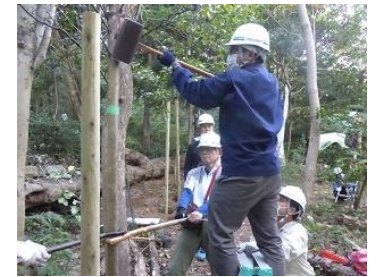
パネル展示用の支柱打ち
