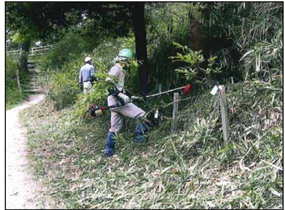
法面のネザサ刈り
