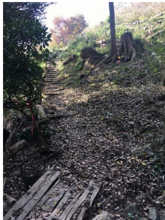
やよいみち入口 標柱設置予定
