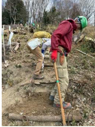
いい感じに進む階段整備
