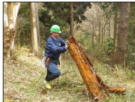
朽腐木の撤去
