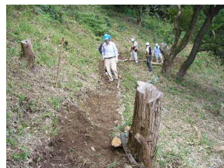
植樹予定地の作業道もほぼ完成
