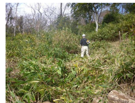
作業道の整備作業
