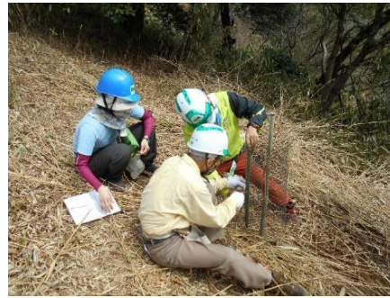
ウッドガード設置
