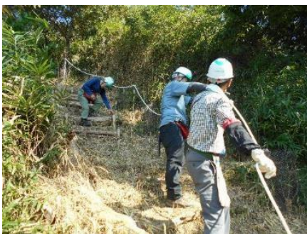
作業道の補助ロープ張り
