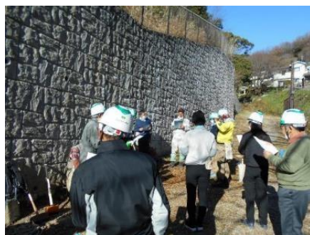
作業前のミーティング
