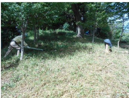
整備作業完了
