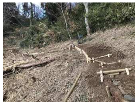
整備された作業道
