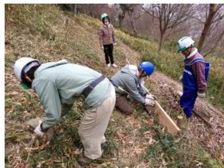
作業道の整備作業
