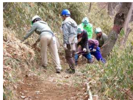
作業道の整備作業
