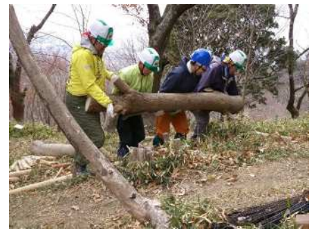
ベンチの設置作業
