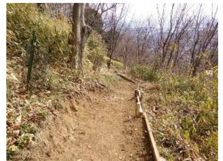
整備後の作業道
