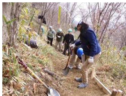
作業道の整備作業
