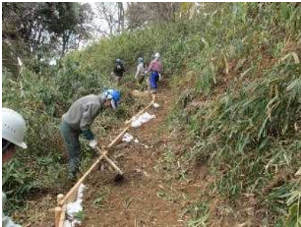
作業道の整備作業①
