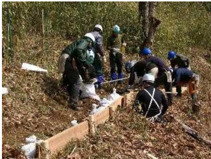
作業道の整備作業②
