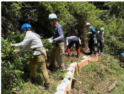
作業道の整備作業
