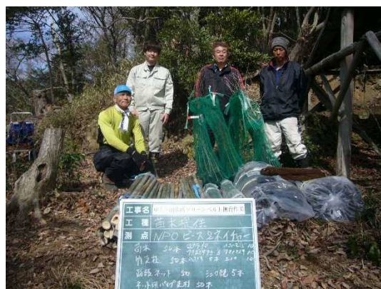
多くの資材を 1 回で運搬していただきました
