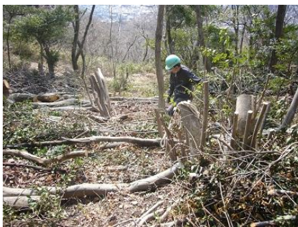
土留めの設置作業
