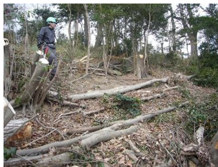
仕上がった表土流出防止の土留め
