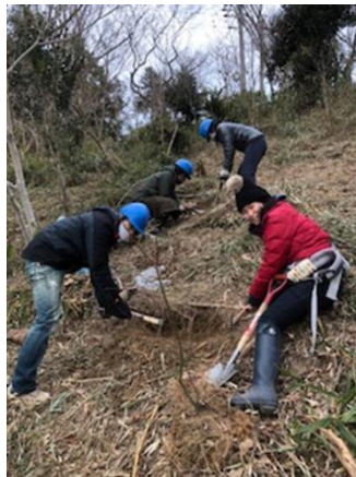
移植スポットの穴掘り
