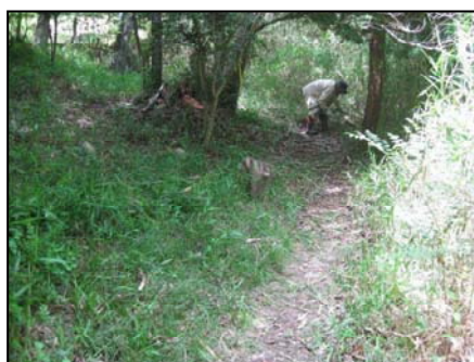
活動地に至る通路の整備
