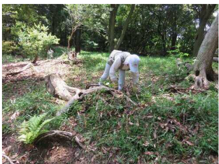
伐採木などの片付け
