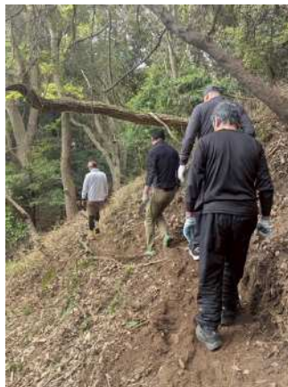
作業道を踏み固めます
