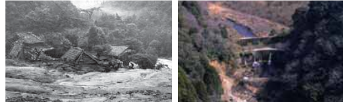
昭和42年災害の様子(市ヶ原付近) 市ヶ原えん堤
