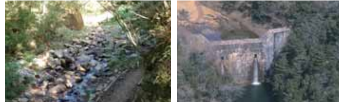
トゥエンティクロス 二十渉えん堤
