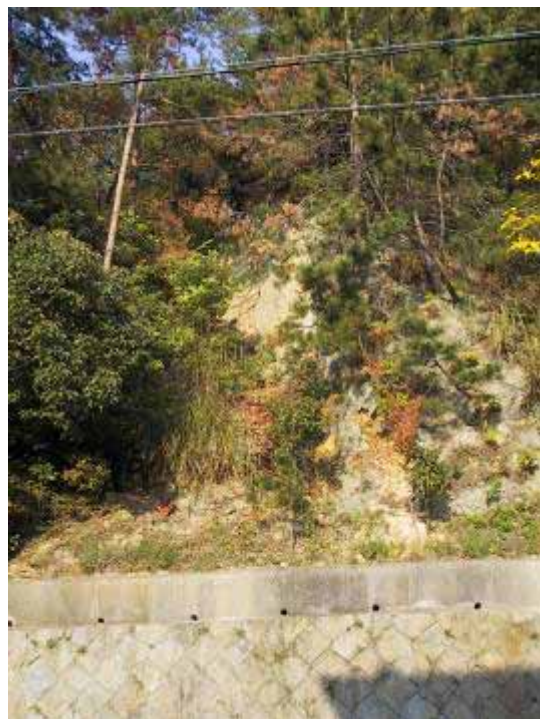
甲陽断層が確認された場所(現在の様子)
