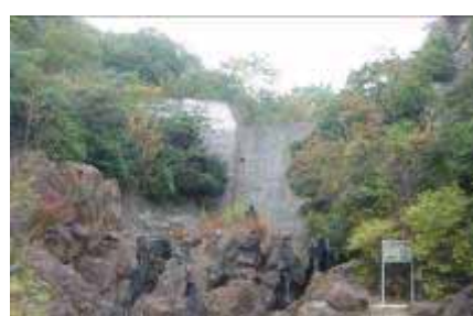
水分谷えん堤
