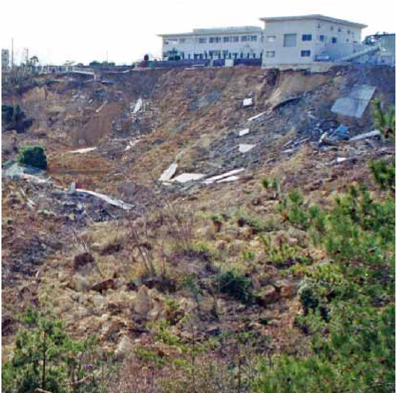
山崩れの様子(阪神・淡路大震災、仁川百合野町)
