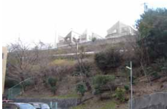
甲陽断層上を走る道路下のがけの様子
