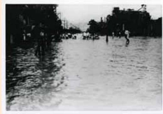
西宮市役所付近の浸水
