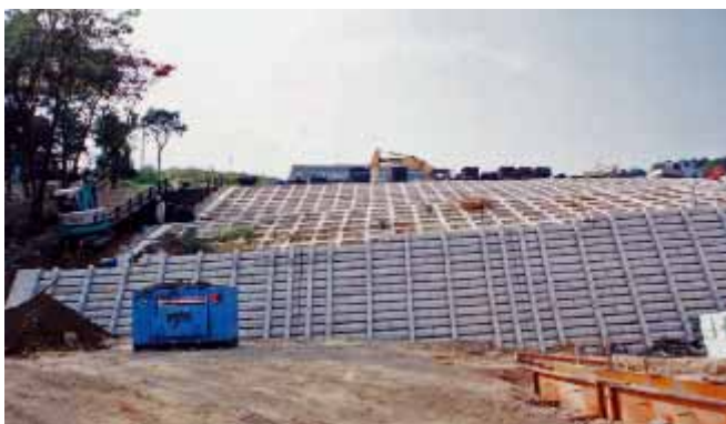
対策工事の様子
