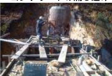
・コンクリートを流し込む枠を設けます
