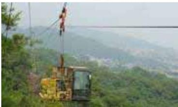
作業する機械や材料は、ケーブルクレーンなどを使って運びます。
