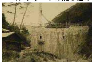
外側に石を積み上げた後、内側にコンクリートを流し込みます。これを繰り返します。
