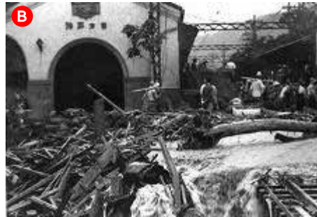
神戸市灘区 阪神電鉄大石駅付近
