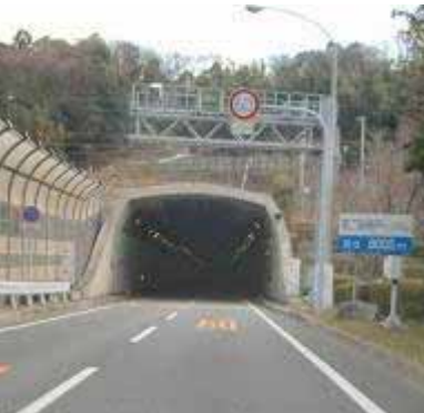
第2新神戸トンネル箕谷入口付近
