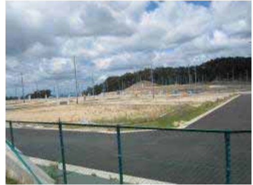
造成中の宅地の様子
