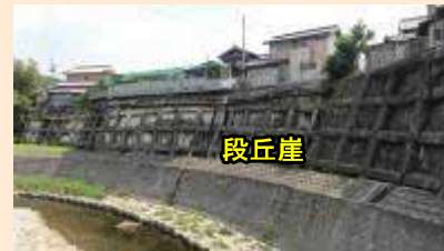
山田小学校付近の河岸段丘の様子
