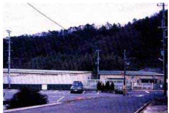
仮設住宅(有馬住宅)
