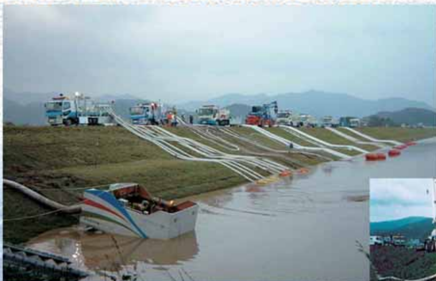
■ 台風23号で氾濫した水を速やかに排除する排水ポンプ車(出石川)
