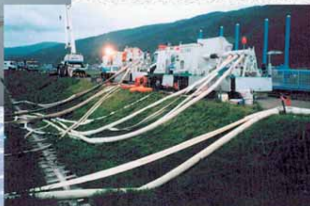
■ 福井豪雨で活動する排水ポンプ車
