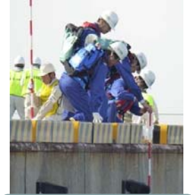
物資輸送の為の港湾施設の点検
