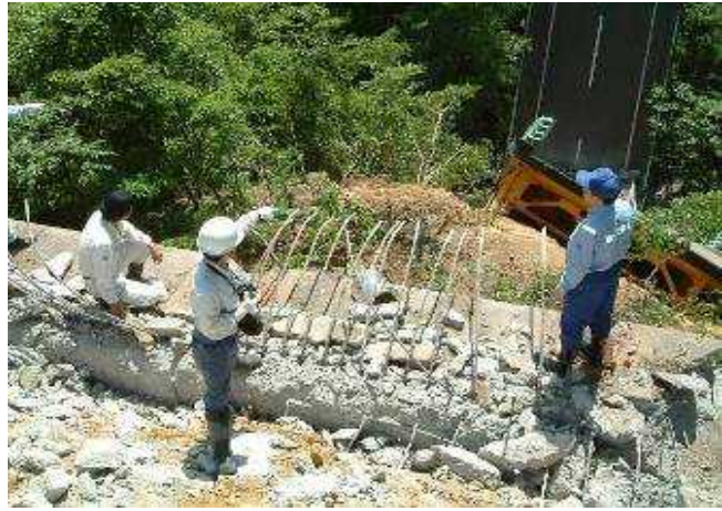
被災状況の調査
