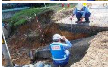
道路の状況調査
