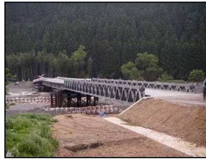
応急組み立て橋
