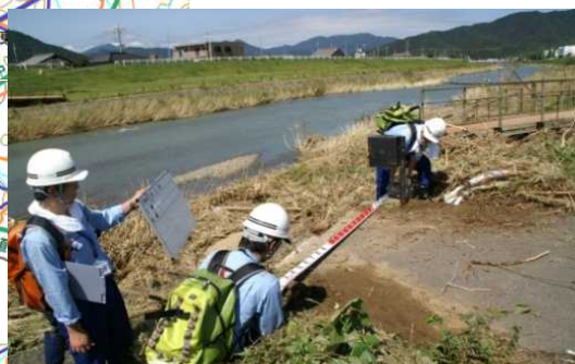
早期復旧に向けた状況把握 (舞鶴市境谷橋)
