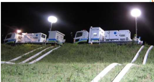
排水ポンプ車による緊急排水 (福知山市荒河地先)
