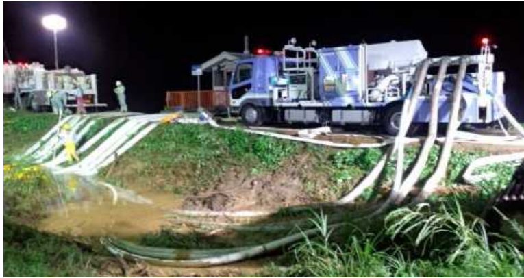
排水ポンプ車による緊急排水
