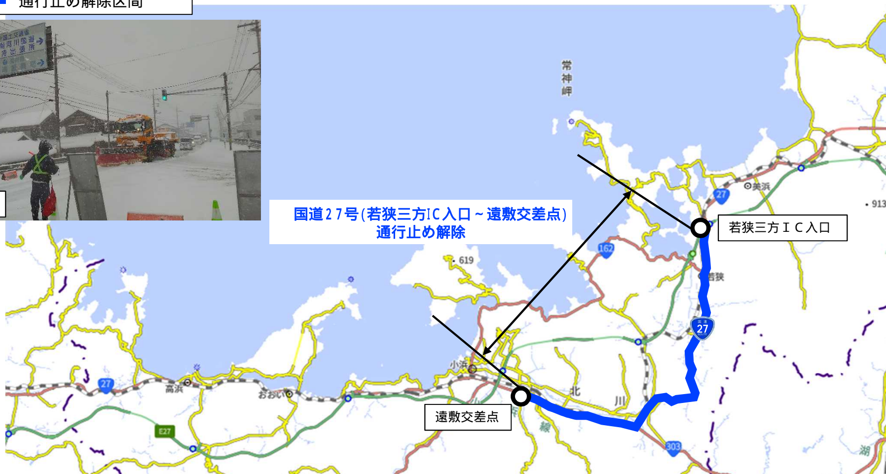
除雪状況写真
