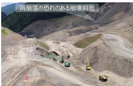
▲ 無人化施工で動く建設機械
