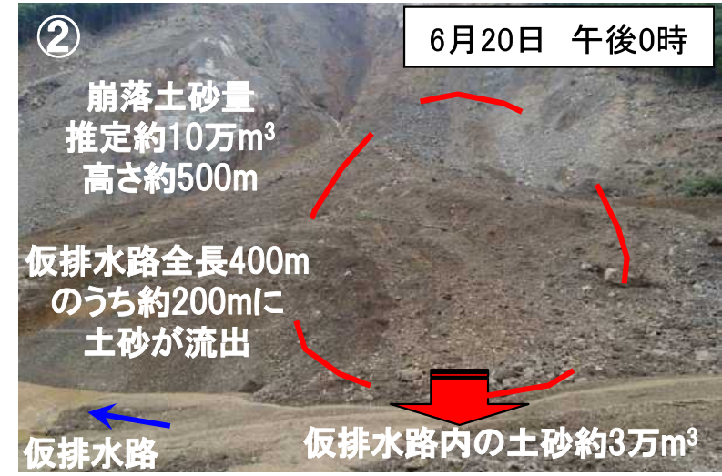
崩壊斜面が一部崩落し、土砂が仮排水路に流出
