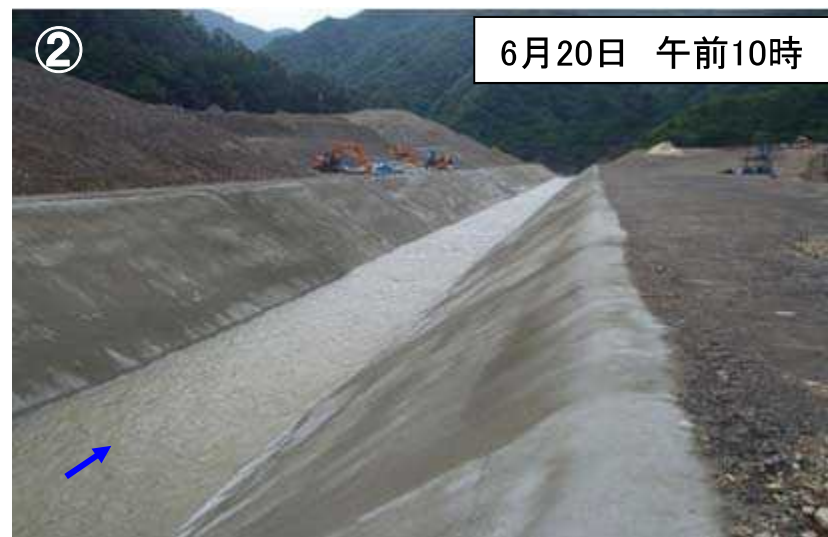
河道閉塞土砂上面の仮排水路の状況
