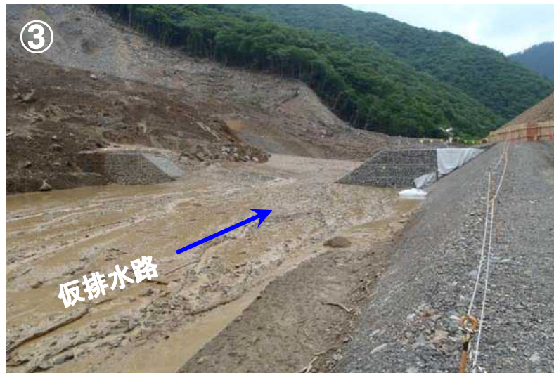
流出した土砂が仮排水路を流下
