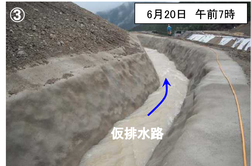
河道閉塞土砂上面の仮排水路の状況
