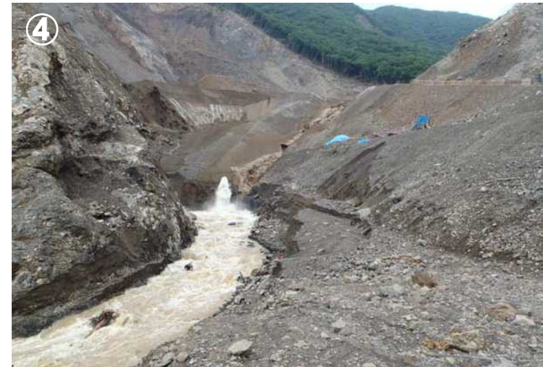
暗渠排水管から湛水池の水が排水
