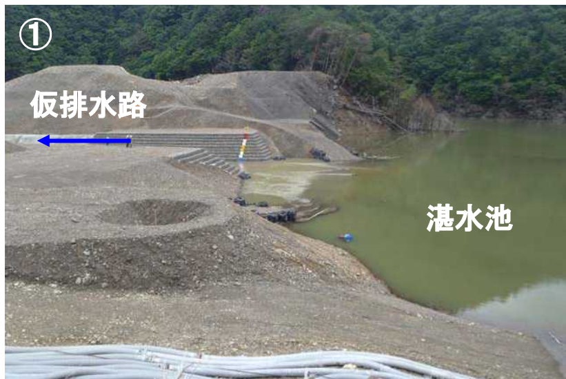
仮排水路の呑口部の状況
