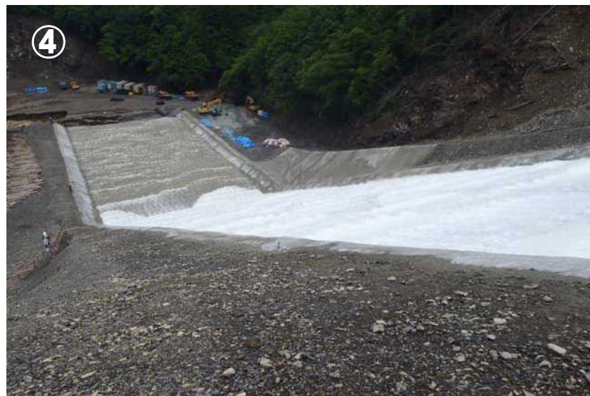
仮排水路斜面部の状況
