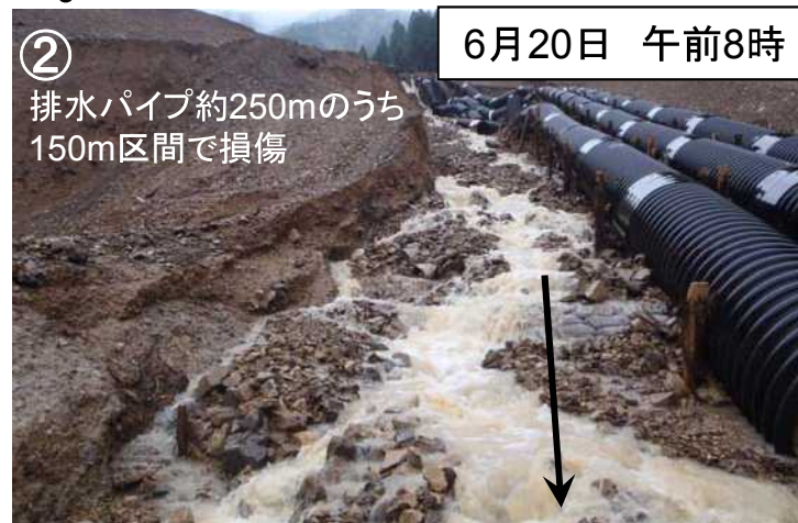
河道閉塞土砂の斜面が侵食し、斜面上部に設置している排水パイプが一部損傷。
