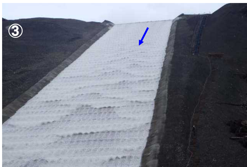
仮排水路斜面部の状況
