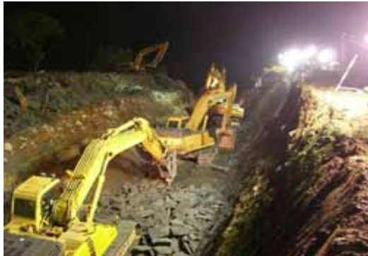
仮排水路掘削イメージ(他事例)
