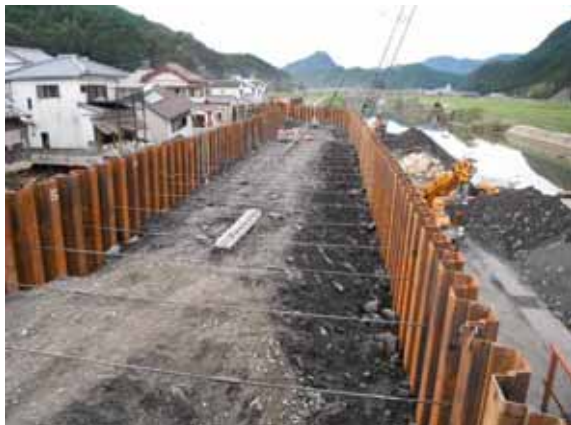
鋼矢板二重締め切りの中詰め状況
