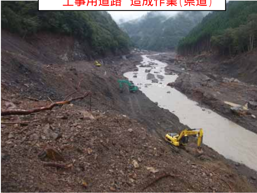
工事用道路 造成作業(県道)
